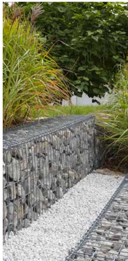
**Le gabion est une cage métallique fabriquée par tressage ou soudage de fils métalliques.**
