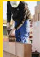
Les blocs sont collés les uns aux autres grâce à un mortier-colle spécial. Cette technique génère des joints particulièrement fins et permet de gagner jusqu'à 30% sur le temps de mise en œuvre.
