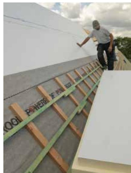
Choix entre panneaux d'isolation Powerroof® ou Powerroof® Maxx avec membrane de sous-toiture.
