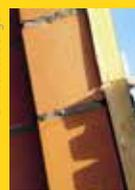
On parle ici de blocs à maçonner avec du mortier. La technique est similaire à la maçonnerie de blocs en béton, en joints horizontaux et verticaux plus ou moins larges.
