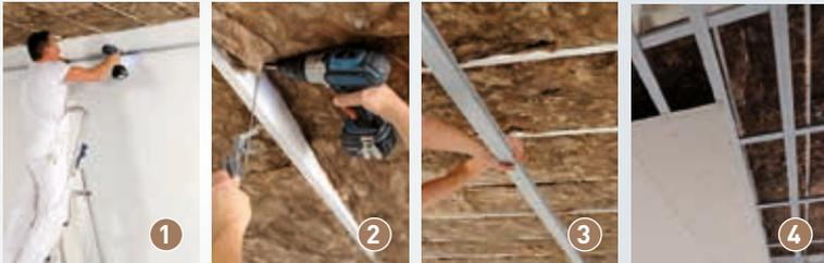
1. Tracer, sur les murs périphériques, la hauteur du nouveau plafond déduite de l'épaisseur de la plaque. Coller, sur la base du profilé KNAUF UD 28/27, la bande d'étanchéité et fixer le profilé à l'aide de chevilles tournantes KNAUF.
